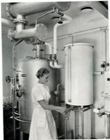
Ångdriven 300 liters destillationsanläggning för vatten installerad i större sjukhusapotek.
